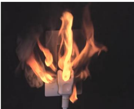
トラッキング現象による事故の再現映像
